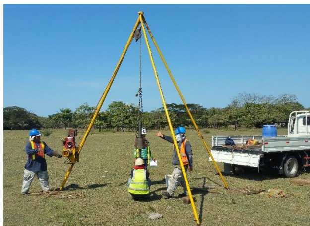
Foto No.7: Realización de Sondeo S.P.T No.4
